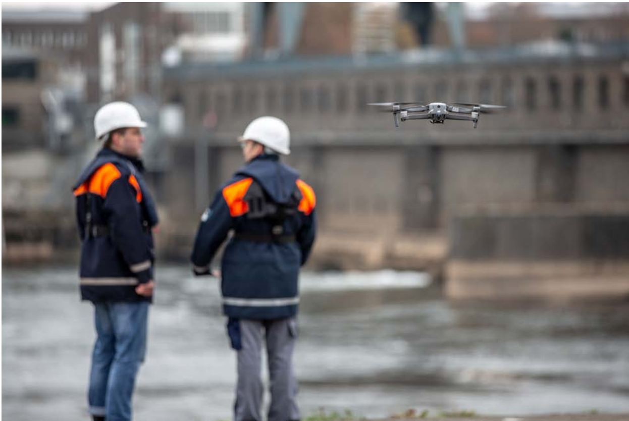
Abbildung 15: Die Erfassung des Zustandes von Bauwerken wird durch den Einsatz von Drohnen erheblich vereinfacht. Dargestellt ist ein Drohneneinsatz am Wehr Koblenz, Mosel am 27.11.2018 (Bild: Bundesanstalt für Wasserbau).
