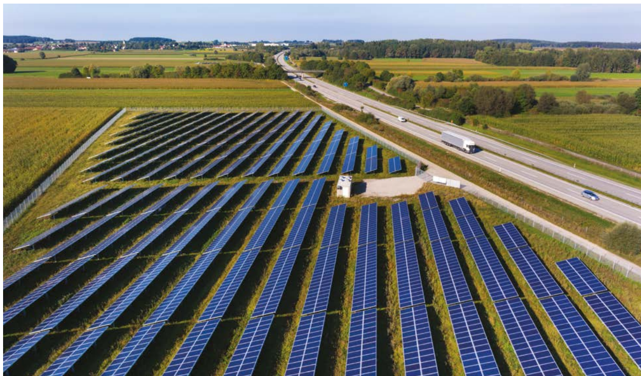
Abbildung 21: Solarmodule an einer Bundesautobahn (Bild: Henglein & Steets/GettyImages)
